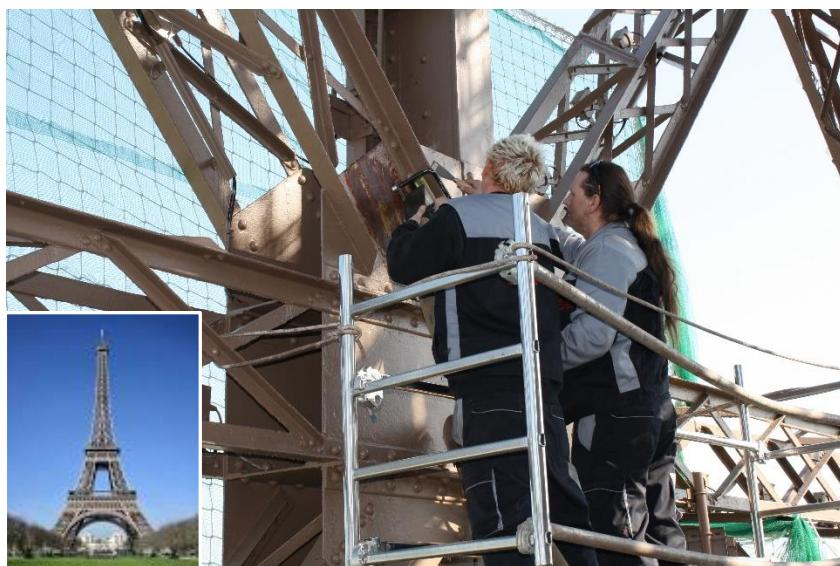
與使用砂礫或水的傳統塗層去除方法相比，用於塗層去除的專利 **RPR** 感應系統具有許多優點。
