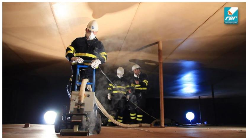
用於去除塗層的 **RPR** 感應系統非常適合快速高效地剝離大面積表面或檢查儲罐中的焊縫。
